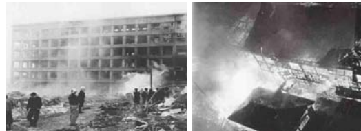
端島小学校（建設中の校舎も焼ける）
