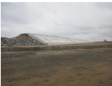
巨大防潮堤の建設（山元町）
