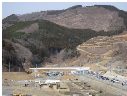
大規模嵩上げによる造成（女川町）
