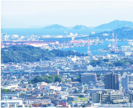
臨海埋立地に造られた製鉄所（福山）
