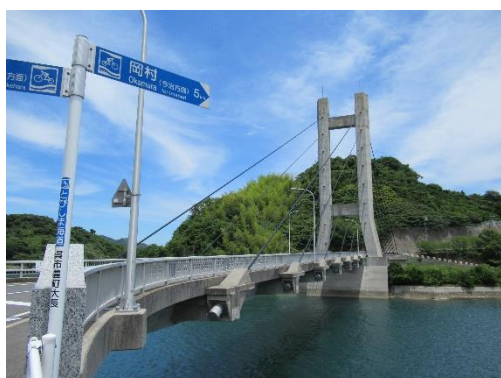
大崎下島から岡村島に至る橋
